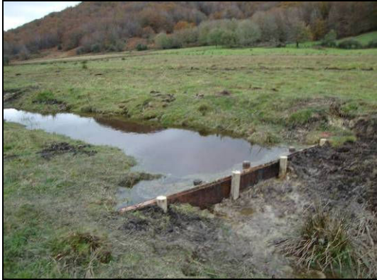
Foto 1: dique n° 2 donde además del dique de madera se puede observar el reforzamiento de este con arcillas
