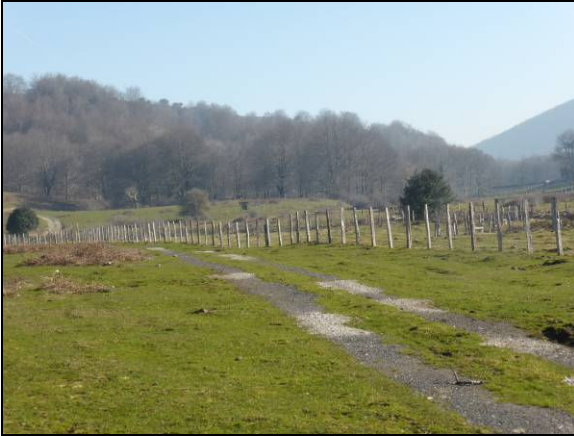
Foto 1: Antiguas rodadas en tierra mejoradas con ofita
