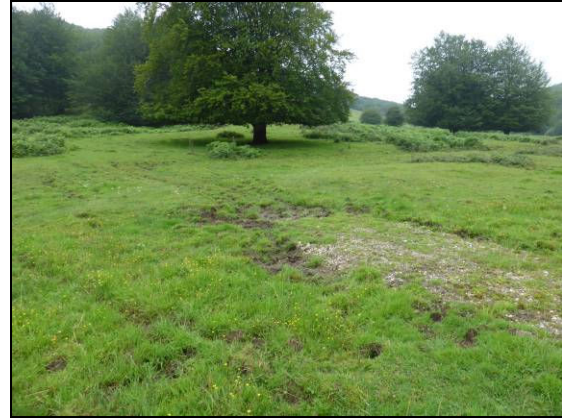
Foto: badén 2 de balasto (menos transitado) en proceso de "naturalización" (ejecutado en 2013)
