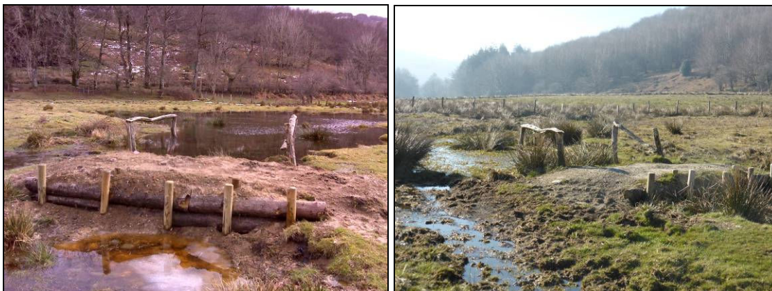
Foto: paso para ganado recién ejecutado y margen derecha inundada. Foto: el mismo dique un año después.
