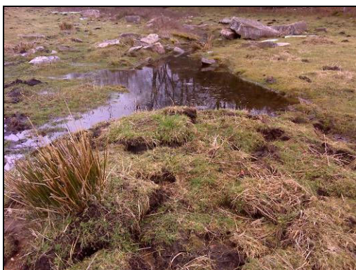
Foto 1: Dique de tierras. Se observa el efecto presa producido
