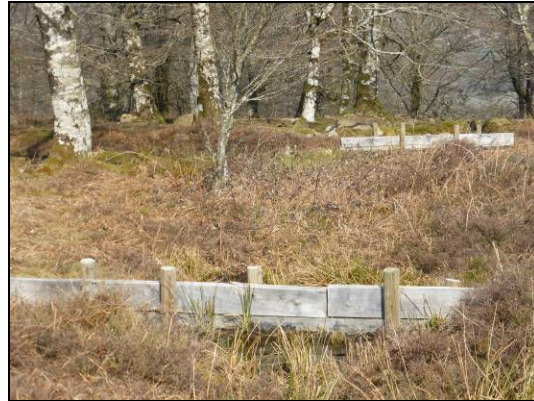
Foto: dique N°8
