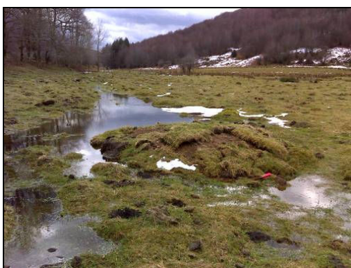
Foto 3: Dique de tierras de cabecera en un canal de drenaje y su efecto. Se pueden distinguir los tepes vegetales situados sobre el dique.
