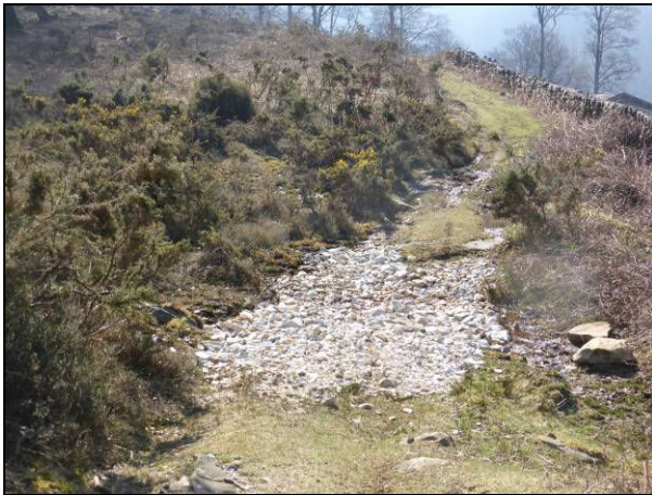
Foto. Balasto y gravas recién depositadas. Desde este mismo momento, el paso de vehículos no genera rodadas.
