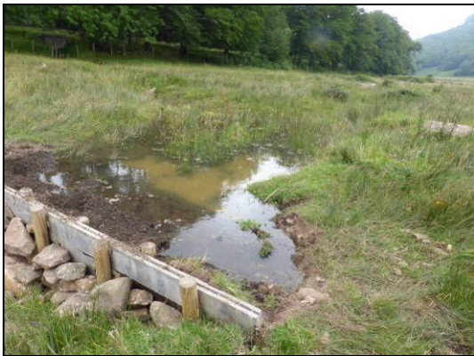
Foto 3: Dique n°1. De la misma forma que en los anteriores, se observan los postes de madera situados al "tresbolillo" que fijan el dique al terreno. En este caso, se han añadido piedras aguas abajo con el fin de evitar la erosión producida por el salto de agua.
