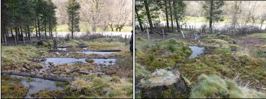
Foto: dique nº1, 2, 3 y 4. Se observa claramente el desarrollo de un tapiz de vegetación aguas arriba de los diques
