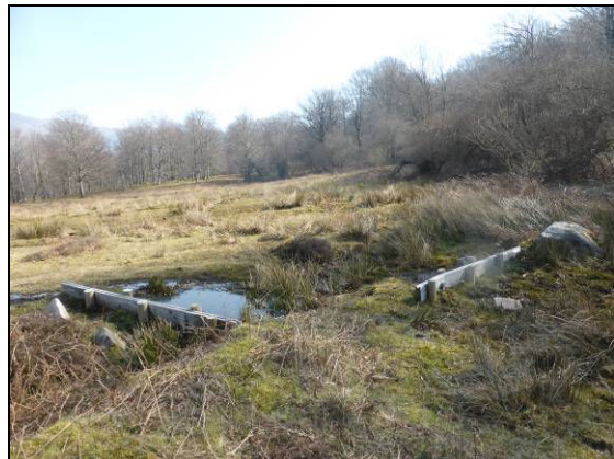
Foto: diques N°2 y N°3
