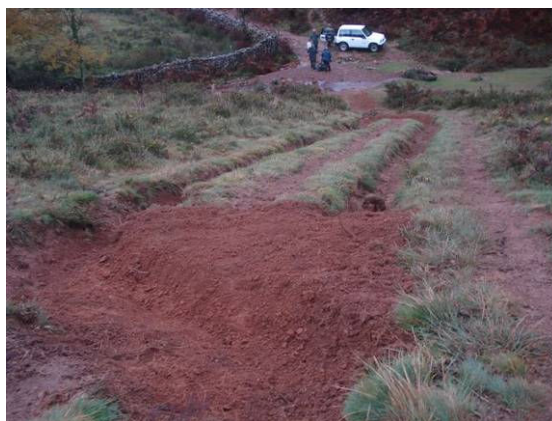
Foto: Barrera 1 Foto: se observa el drenaje transversal realizado para derivar el agua de escorrentía al drenaje de la pista.
