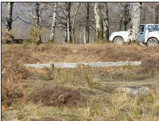
Foto: dique N°4
