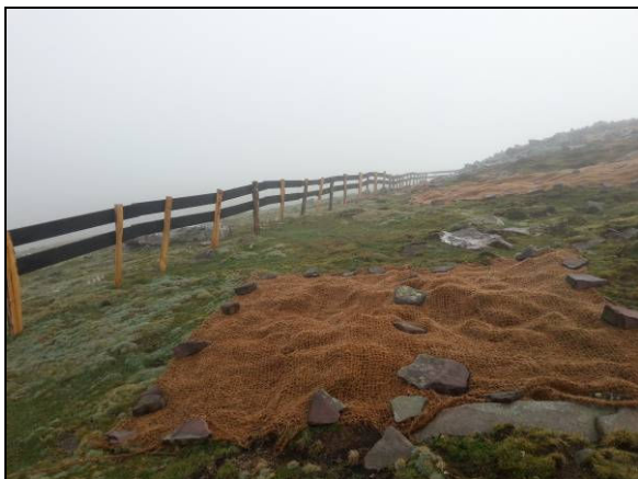
Foto: malla de fibra vegetal protegiendo las zonas erosionadas de Xuriain. Esta fijada mediante barras de acero corrugado y por piedras del lugar.
