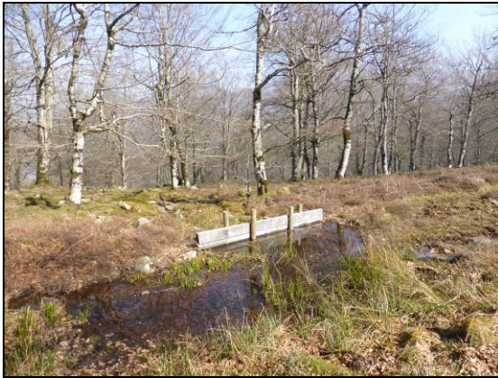
Foto: desarrollo de vegetación aguas arriba del dique después de un año de su instalación:
