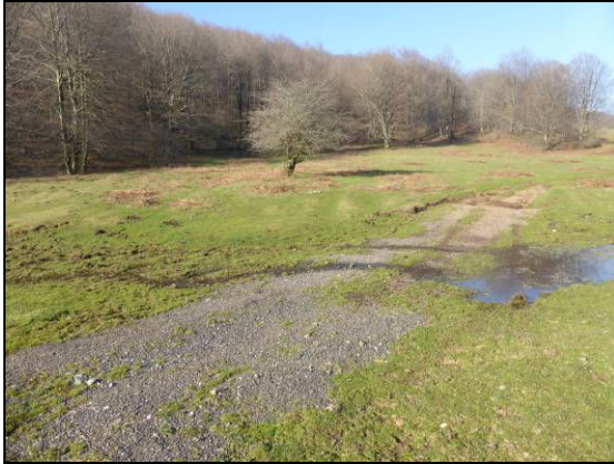
Foto: badén 1 de balasto en intersección con pequeña regata ejecutado durante el año 2013. Este badén es el más transitado por lo que su revegetación y naturalización está siendo más lenta (tal y como se observa en la fotografía).
