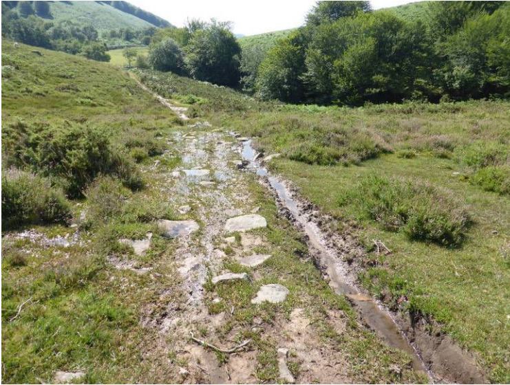
Foto 4: ramal C que cruza el humedal. Se observa el impacto en el flujo natural del agua así como el estado del firme.
