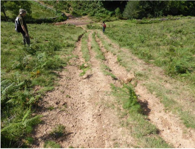
Foto 2: Ramal A de la pista.
