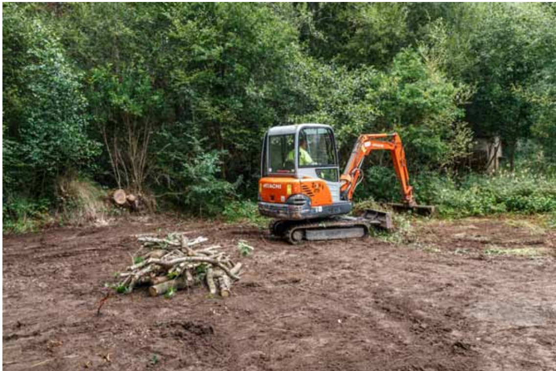
Imagen 9.- Trabajos de retirada de vegetación, corrección topográfica y preparación del terreno en los Ollos de Begonte
